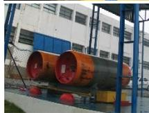
Cloração: utilizado para eliminar os microorganismos que resistem as etapas anteriores.
