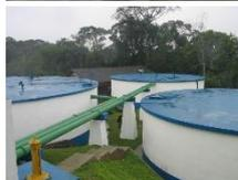
Reservação: concluído o tratamento, a água é armazenada em reservatórios com capacidade de 9.500m³ de água e em seguida distribuída.
