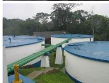
Reservação: concluído o tratamento, a água é armazenada em reservatórios com capacidade de 9.500m³ de água e em seguida distribuída.
