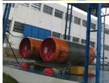
Cloração: utilizado para eliminar os microorganismos que resistem as etapas anteriores.
