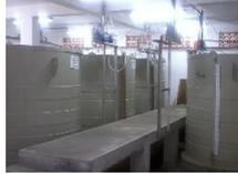
**Fluoretação e correção de pH:** o flúor é adicionado para auxiliar na prevenção da cárie e alcalinizante para neutralizar a acidez da água.
